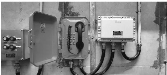
图 11 防爆型固定电话、机箱、连接部件
