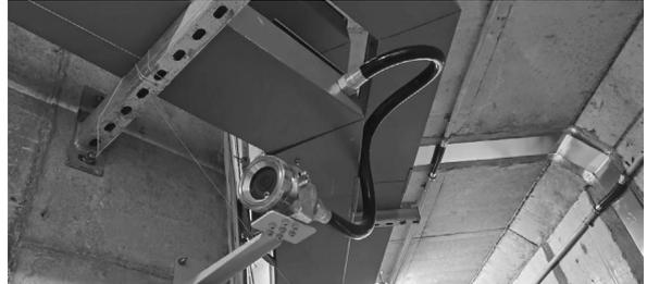
图 12 防爆型摄像机、连接部件
