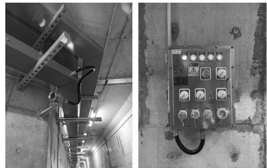
图 6 燃气舱相关防爆配件
