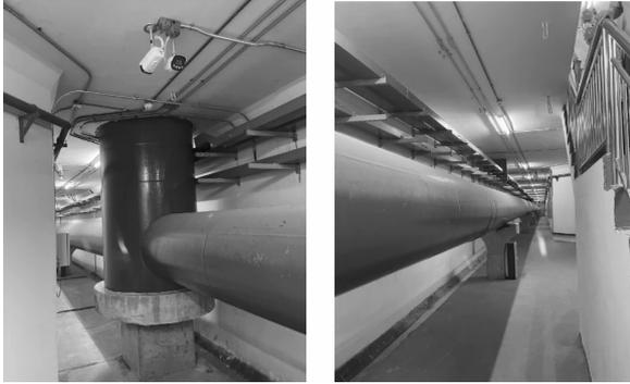
图 4 重力污水管道舱
