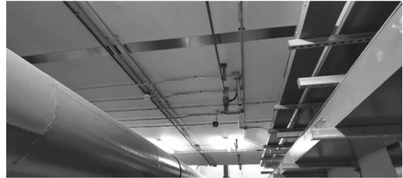
图 10 感温光纤、摄像机、超声波水位探测器安装情况
