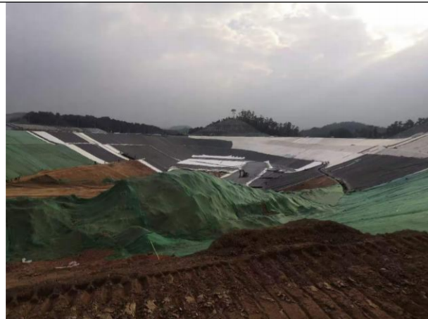
拍摄时间: 2020 年 3 季度 现场情况: 库区已完成开挖边坡开始边坡防渗系统施工, 暂不施工区域实施临时覆盖措施
