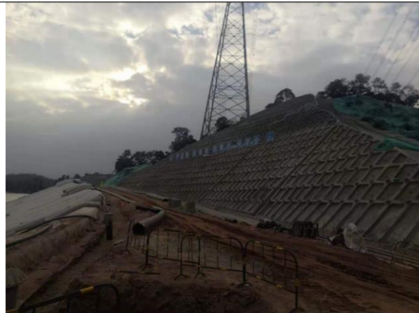
拍摄时间: 2020 年 3 季度 现场情况: 开挖边坡实施锚杆+喷砼防护
