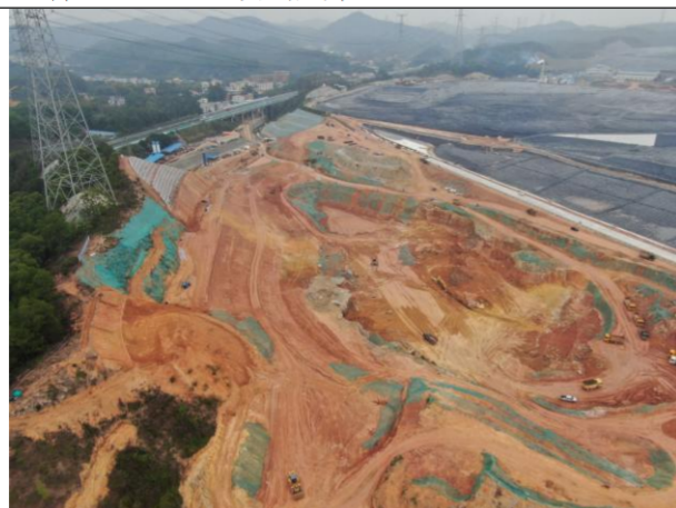
拍摄时间: 2020 年 1 季度 现场情况: 库区正在进行土方开挖, 部分区域实施临时覆盖措施
